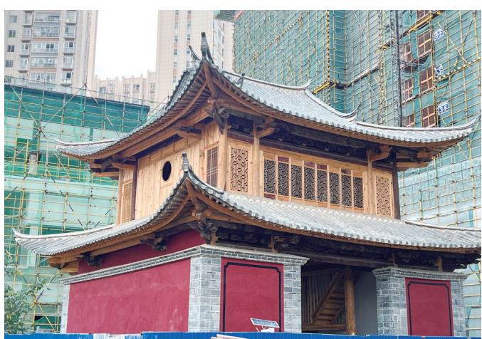
文山市小西门城墙修缮中
